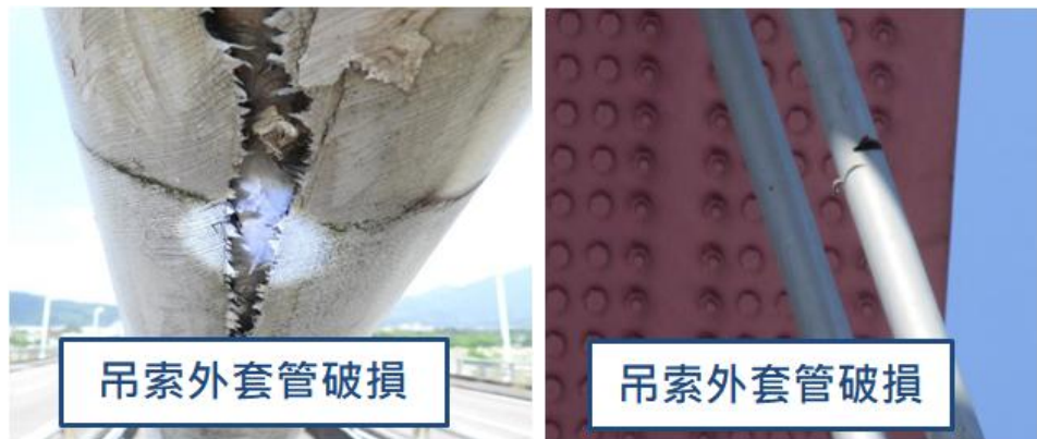
特殊構件檢測現場照片(參考交通部特殊性橋梁研習資料)
