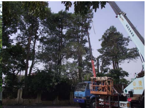
吊車固定吊籃作業
