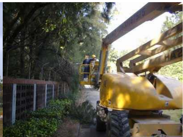
高空作業車作業
