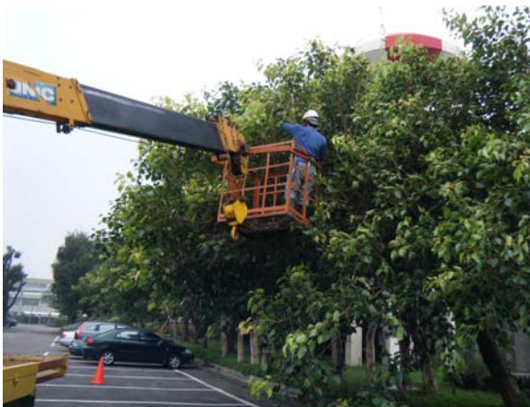
吊車固定吊籃作業
