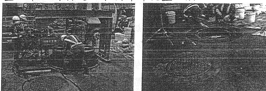
4. 中華電信研發調降孔蓋水平切割工法。
